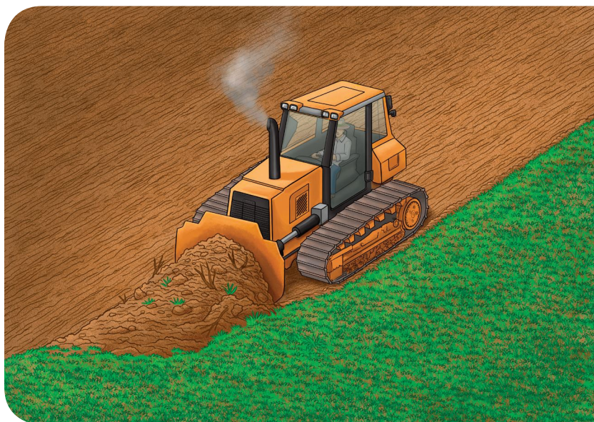
Raspagem da superfície do terreno
