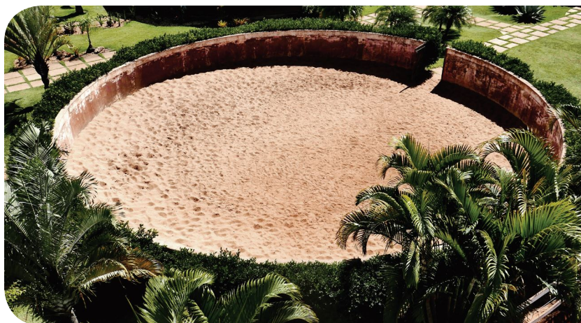
Redondel de alvenaria
