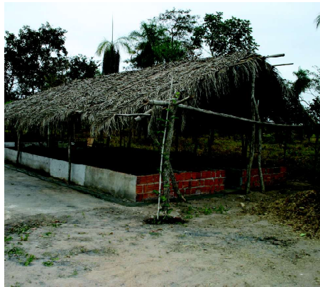
Cobertura de palha acima dos canteiros
