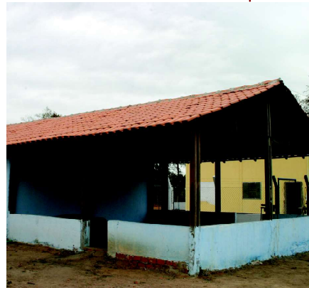
Cobertura de telha acima dos canteiros
