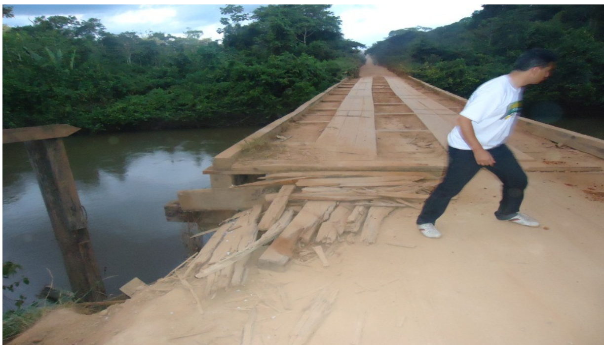
Foto 13 – Ponte danificada sobre o rio Natalzão
