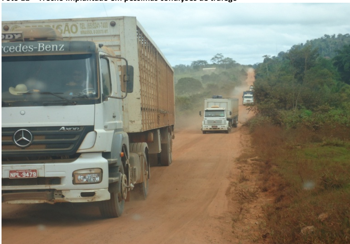
Foto 11 – Trecho implantado em péssimas condições de tráfego
