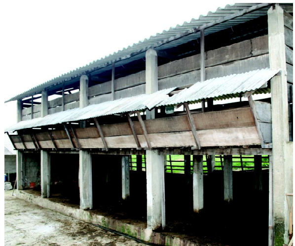
Galpão com piso ripado
