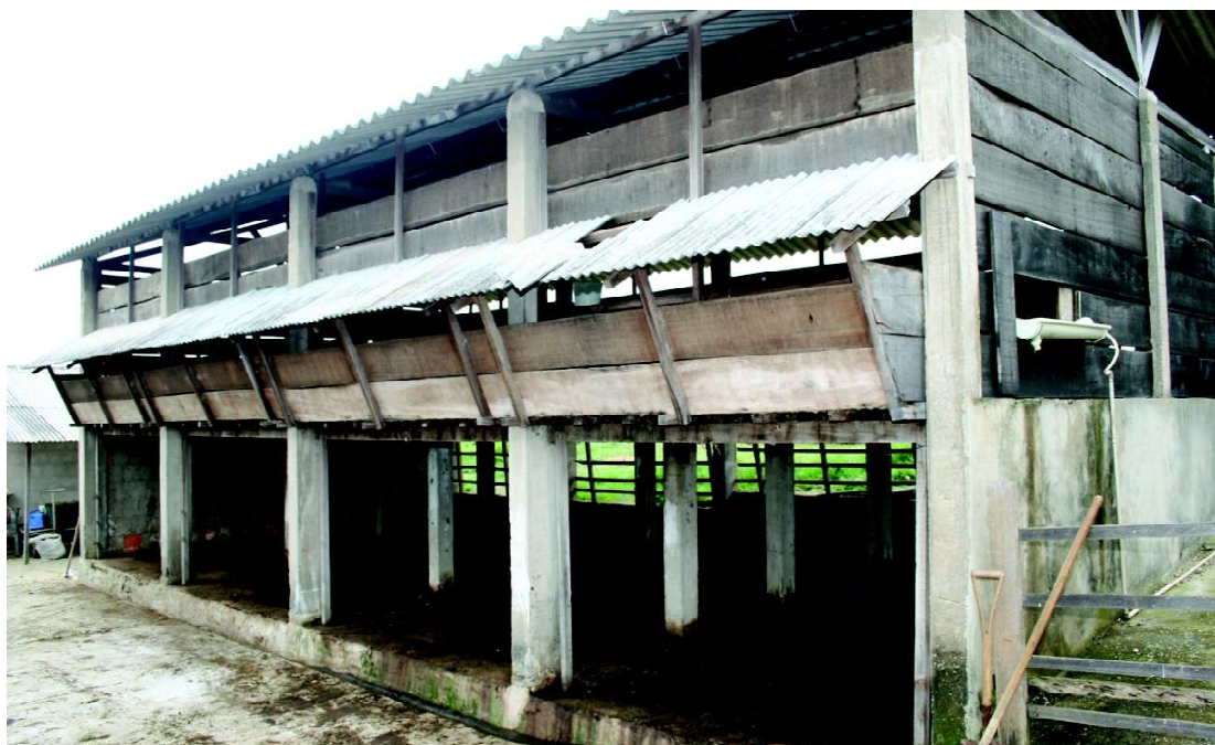
Altura do piso em galpão
