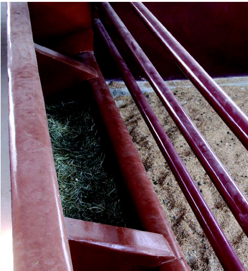
Cocho de alvenaria
