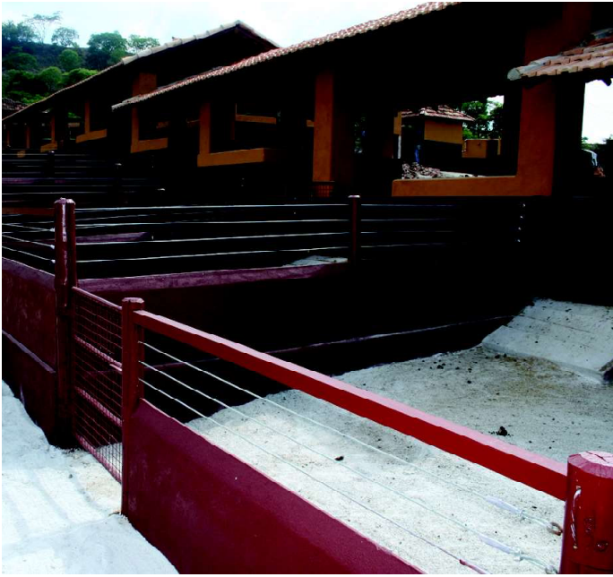
Galpão com divisória
