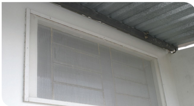
Janelas com telas para impedir a entrada de insetos
