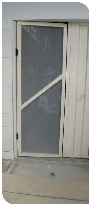
Portas com telas de proteção
