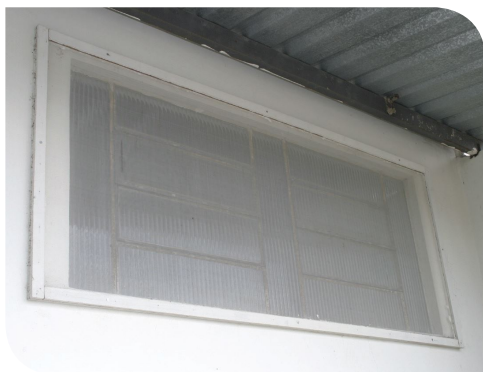
Janelas com telas de proteção
