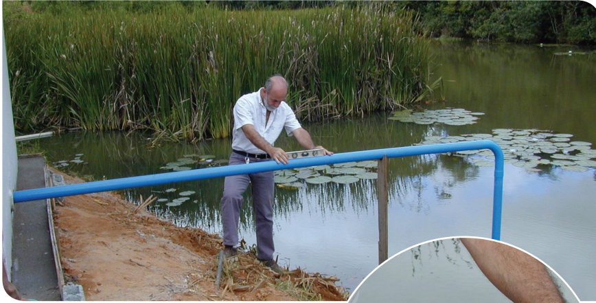
3.10.7 - Nivele o conjunto de sucção com um nível de pedreiro
