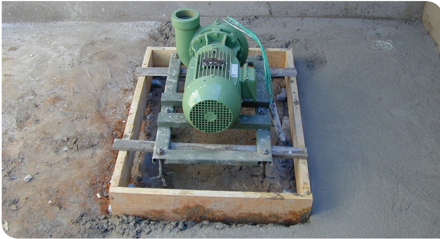
Motobomba apoiada sobre os travessões
