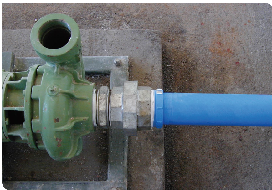
Bocal de saída da bomba com 65 mm de diâmetro e conexão tipo rosca
