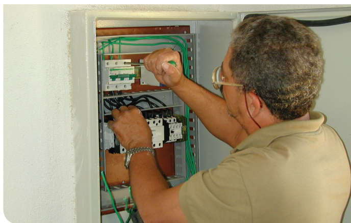
Montagem do quadro de comando e proteção do motor elétrico
