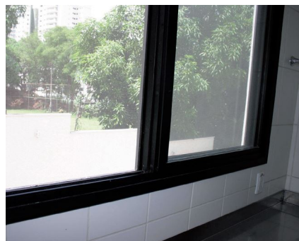
Janelas grandes com redes de proteção
