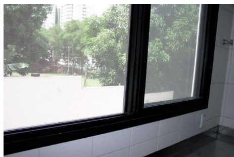
Janelas grandes com redes de proteção
