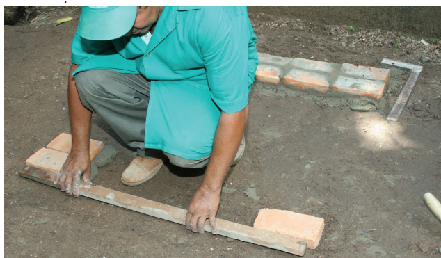
c) Confira a distância entre o tijolo assentado e a marcação realizada
