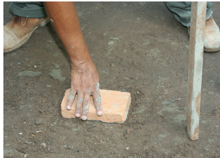
c) Confira a distância entre o tijolo assentado e a marcação realizada
