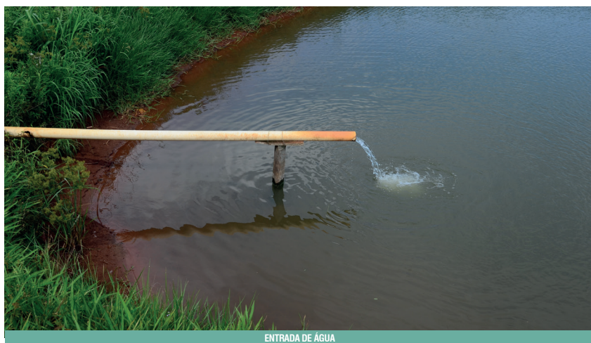
ENTRADA DE ÁGUA
