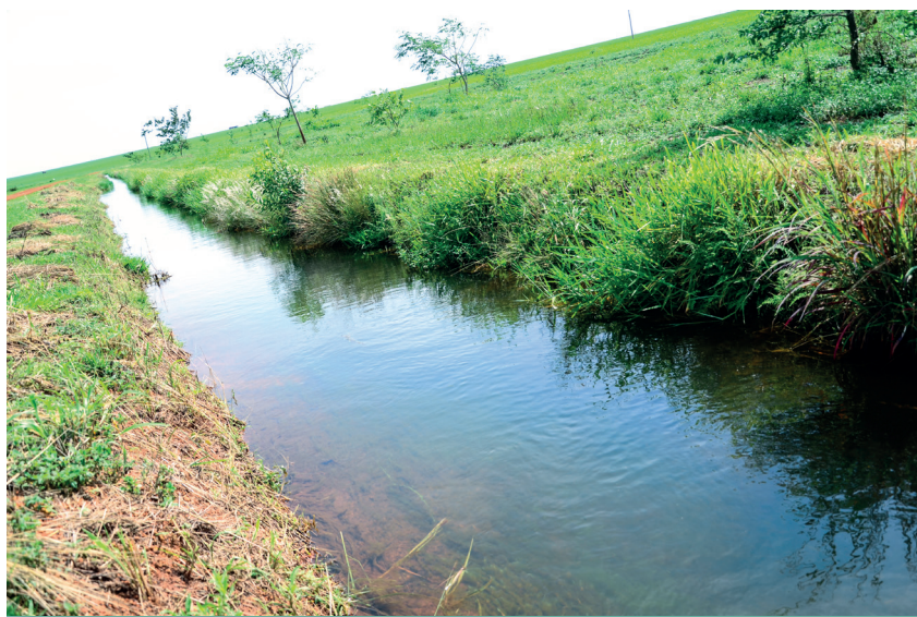
CANAL DE ESCOAMENTO
