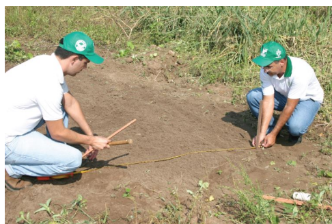
5.8.3 FINQUE A OUTRA ESTACA NA LARGURA DETERMINADA
