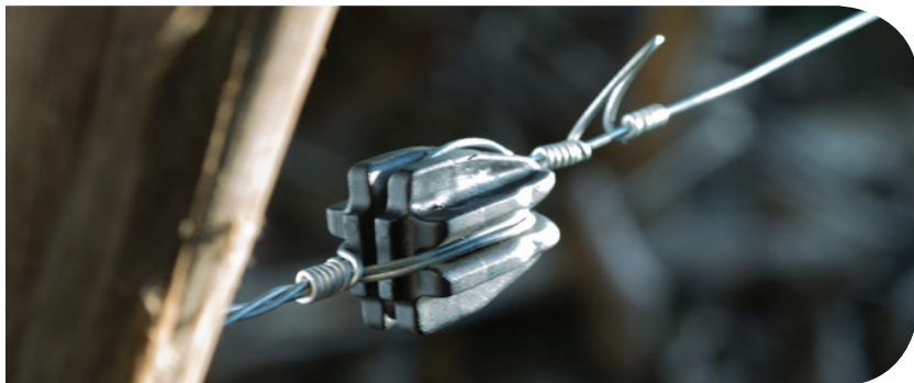
Isolador de canto instalado
