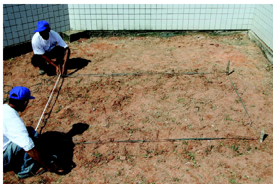
1.1.18 CONFIRA A LARGURA DA OUTRA LATERAL DO CANTEIRO
